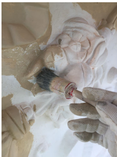
Till vänster: Närbild på impregneringsmålningen. Till höger: Frisen är impregnerad. Foto: Björn Forsman.
