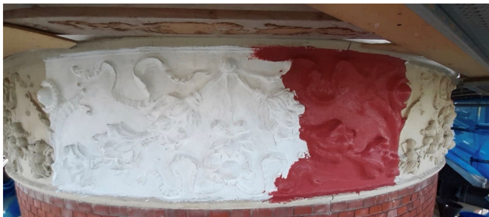
En rapport av stuckfrisen förses med silikongummi och stuckgips. Foto: Daniel Hillman.
