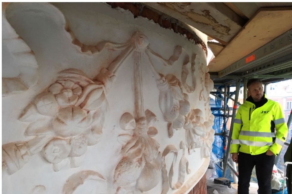
Montage av stuckfrisen pågår: Den övre profillisten saknas ännu. Foto: Karl-Magnus Westrin.
