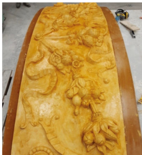
Till vänster: Schellack som grund till lerpåläggning. Till höger: De färdiga stückelementen, i väntan på leverans till Karlaplan. Foto: Daniel Hillman.
