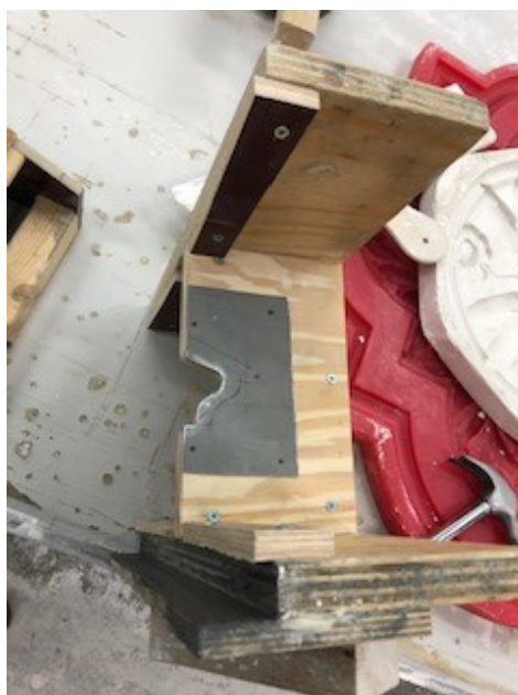
Till vänster: Den träbåge som fungerat som underlag för att motsvara tornets form. Till höger: Den släde för listdragning som använts vid nyttillverkning av profilerade stucklistor. Foto: Daniel Hillman.
