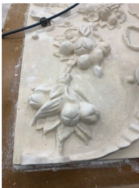
Rekonstruktion av bortfallna ornament på stuckfrisen pågår. Foto: Daniel Hillman.
