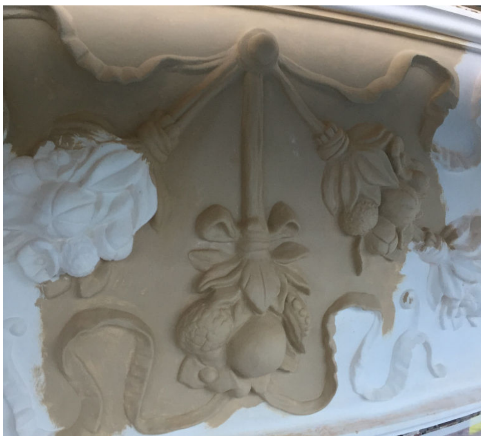
Impregneringsarbetet pågår. Foto: Björn Forsman.
