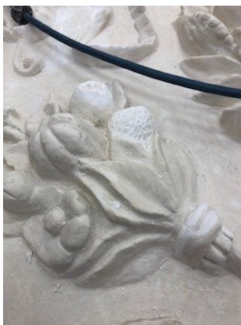
Rekonstruktion av bortfallna ornament på stuckfrisen pågår. Foto: Daniel Hillman.
