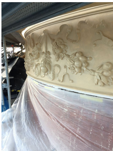
Till vänster: Närbild på impregneringsmålningen. Till höger: Frisen är impregnerad. Foto: Björn Forsman.
