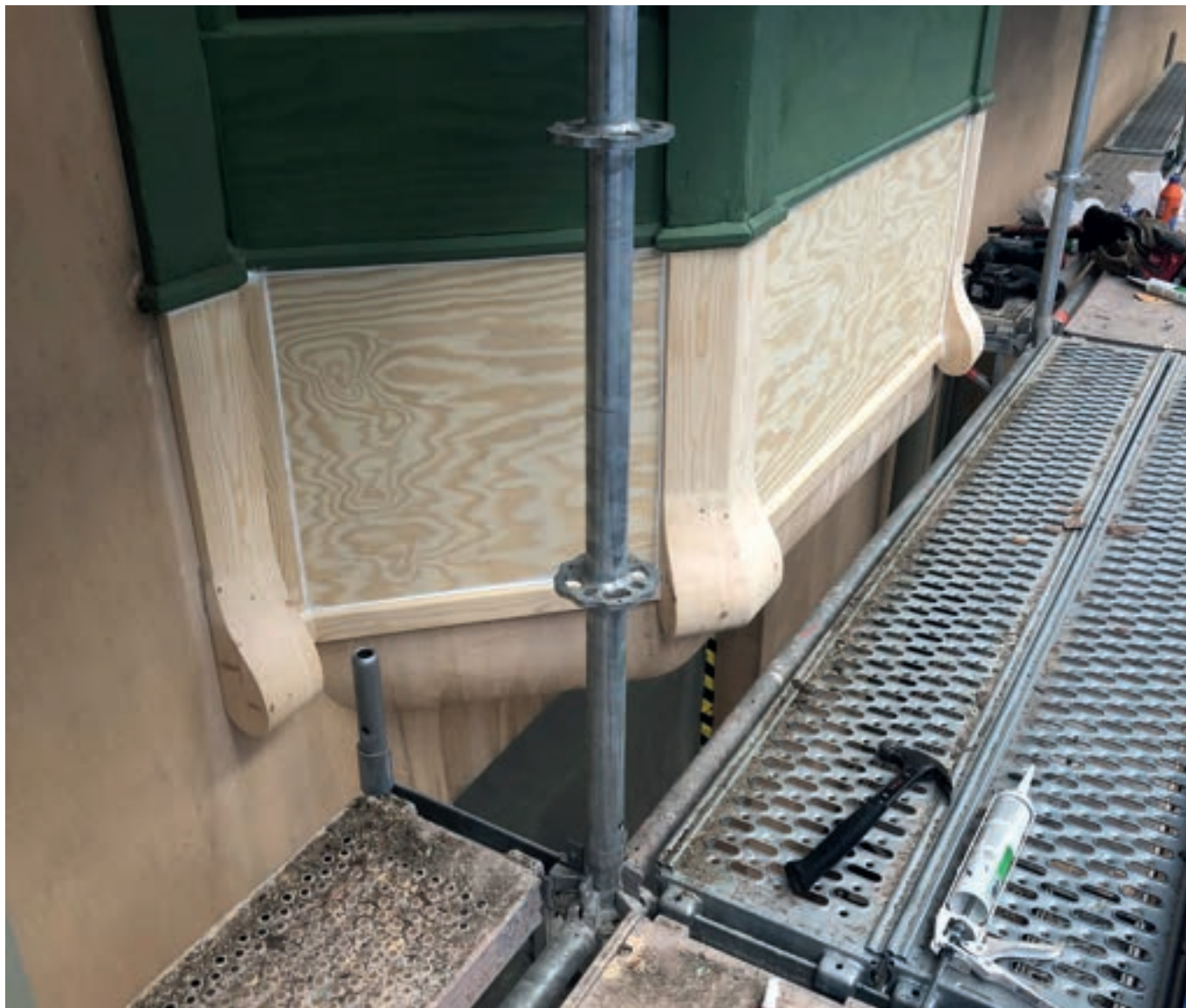
Träburspråkets botten återställs efter originalfotot från 1909. Nya partier av plywood inramas med jugendformade snickerier som bildar en elegant avrundning över burspråkets botten.
